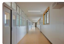
附属中学校校舎改修 (2020年度竣工)
